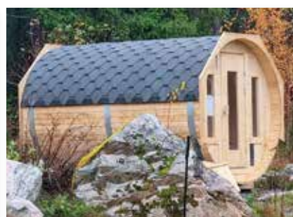
Runt tak med grått takshingel.
