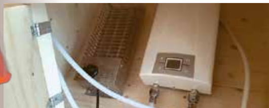
Värmelåda med frostvakt till genomströmningsberedare.
